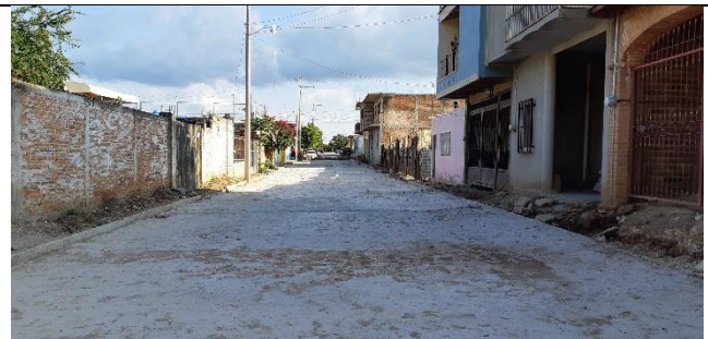
PAVIMENTACION DE LA CALLE LUIS OROZCO
